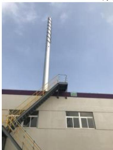
导热油炉排气筒
